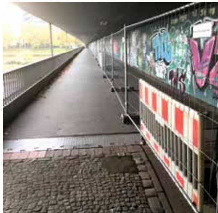
Die Absperrung: Würde man sie entfernen, müsste die freierwerdende Fläche mit einer Last von 234 Tonnen in die statische Berechnung einfließen
