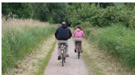
Möglicherweise wird hier bald der Belag erneuert
