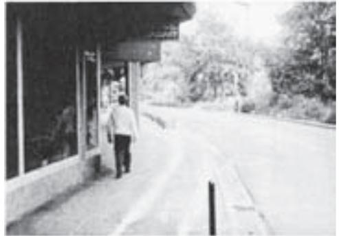
Zu dicht an der Fahrbahn verlief dieser "Radweg" beim ersten Versuch der Bremer Radweg-Pinsler. Inzwischen ist der Schaden behoben, die Fußgänger haben jetzt noch 20 cm weniger als auf dem Foto.
